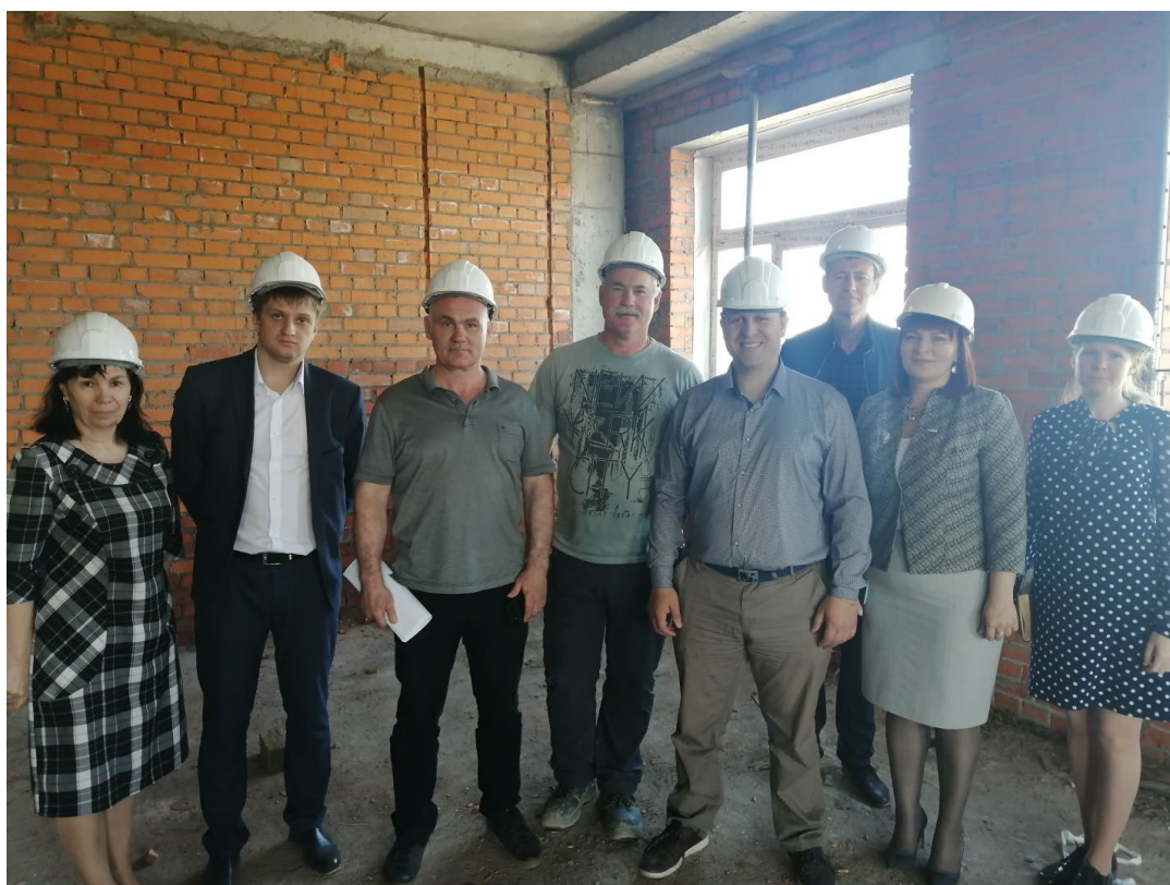
Посещение строящихся объектов – школа с.Мичуринское
