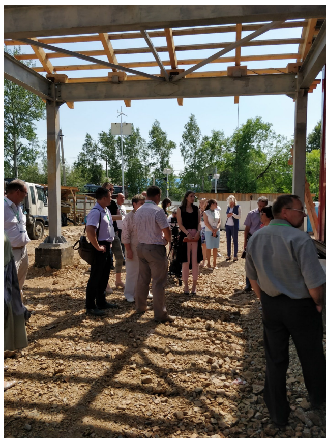
На объекте строительства - амбулатория с.Виноградовка
